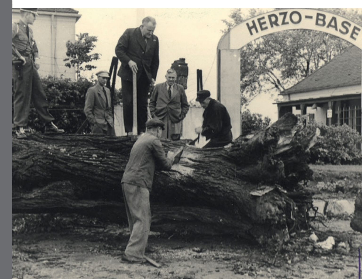
Die Zweimarterlinde am Eingang der US-Garnison wurde 1951 vom Sturm gefällt
